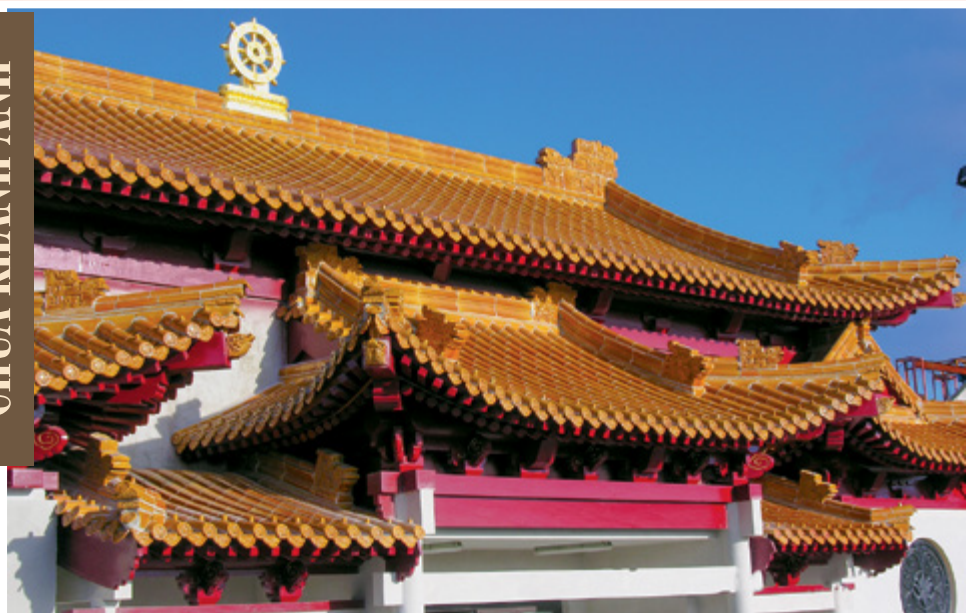
Mái chùa đang hoàn thiện (Ảnh 2007)
