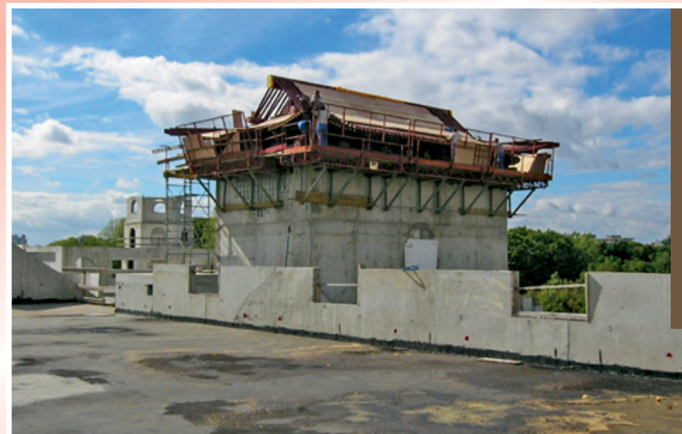
Nóc Chánh Điện đang xây cất (Ảnh 15-9-2005)
