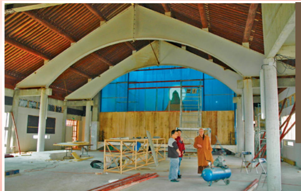
Chánh điện đang được hoàn thiện (Ảnh 2007)
