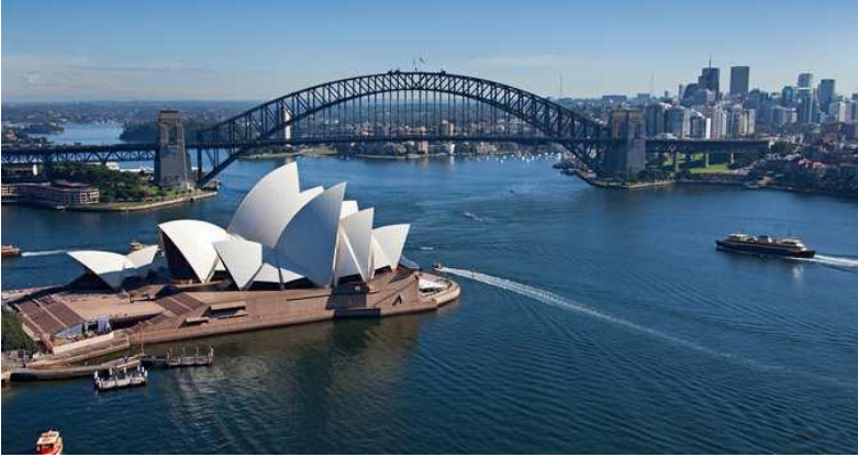
Cầu Sydney Harbor & Nhà hát con Sò Opera House
