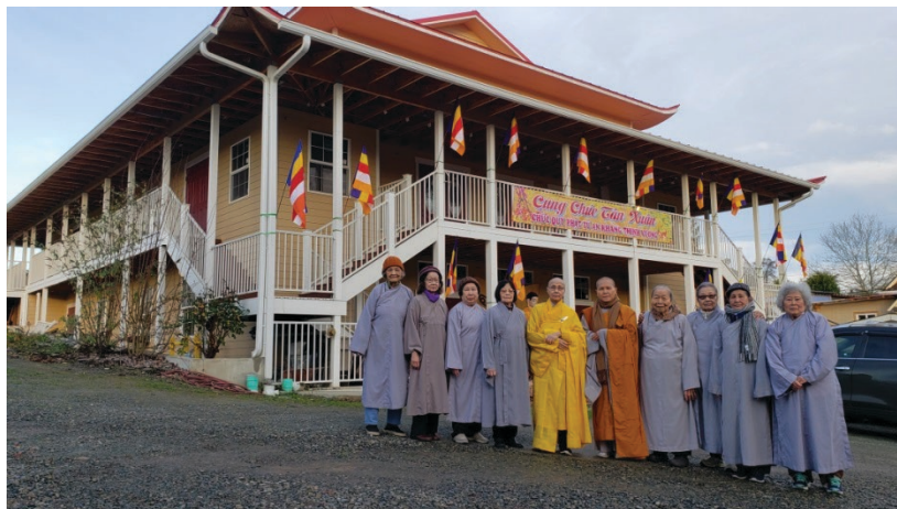
Vạn Hạnh Pagoda under construction The Most Venerable Giác Hương, Bhikkhūnī Giới Hương and Buddhist followers, January 19, 2020
