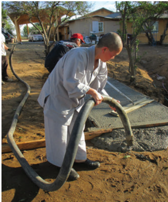
Đổ bê tông, năm 2017
