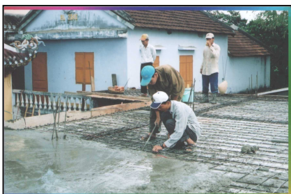
Đổ bê-tông sàn nhà.
