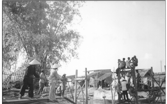
Một trong những cây cầu đang xây dựng.
