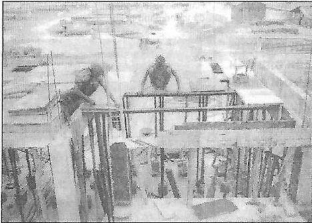
Phần sàn ở ô cuối đang được lắp ráp
