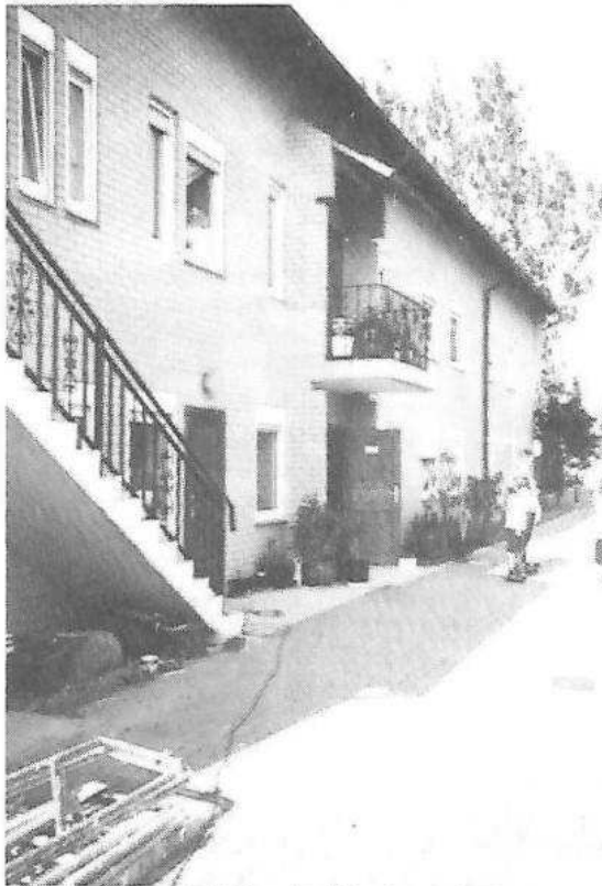
Tường nhà Đông đã được xây gạch xong
