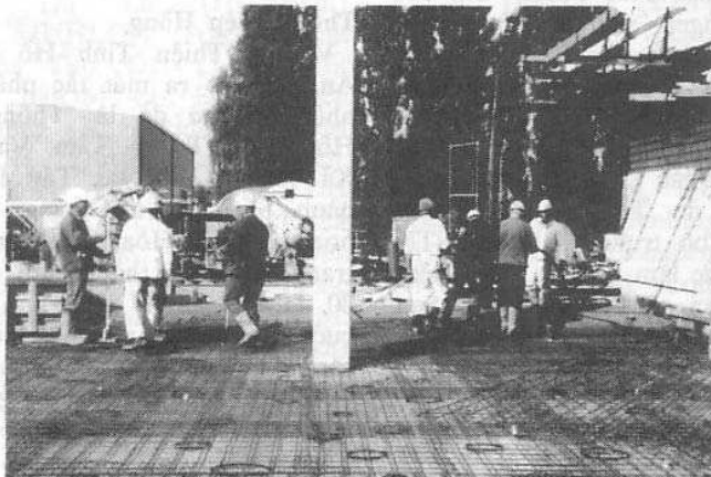
Thợ đổ bê tông nền nhà Đông Đường (7/90)
